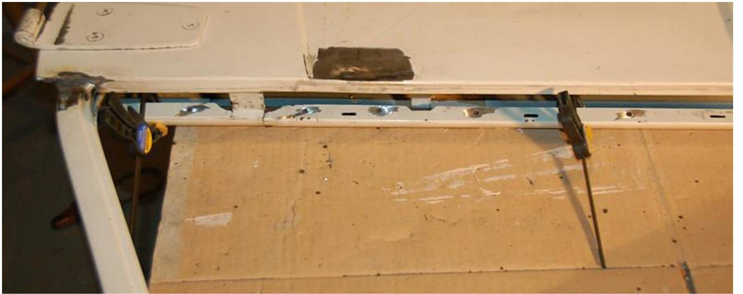
Et ici l'angle est soudé en place. Tout ce j'ai à faire maintenant est de broyer ces soudures fiche plate afin qu'ils n'interfèrent avec le coupe-bise de la fenêtre et souder jusqu'à la fissure dans la tôle. La fissure ne se répéteront pas maintenant que ce renforcement est en place.
